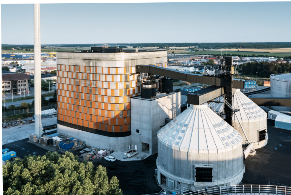
Biobränsleanläggningen Carpe Futurum Uppsala. Bildkälla: Vattenfall Värme AB
