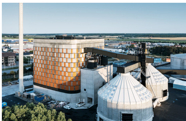
Biobränsleanläggningen Carpe Futurum Uppsala
