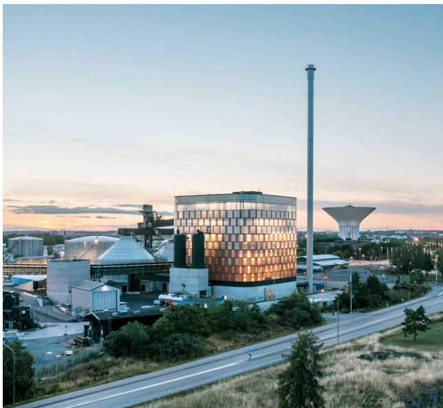
Biobränsleanläggningen Carpe Futurum Uppsala
