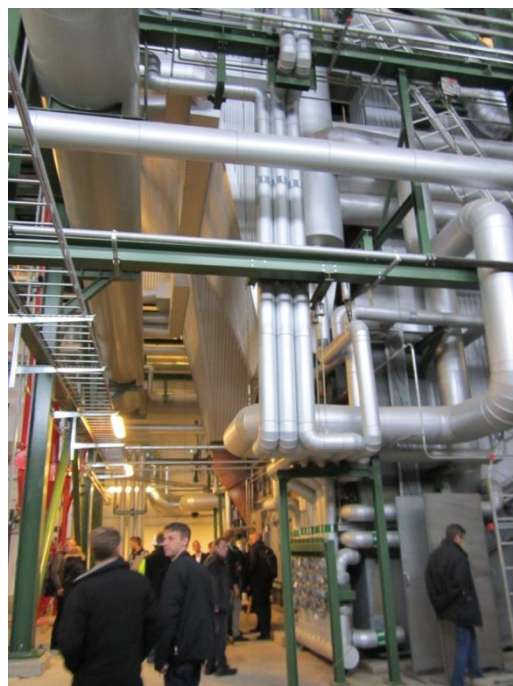
Efter föredragen följde ett studiebesök på Filbornaverket
