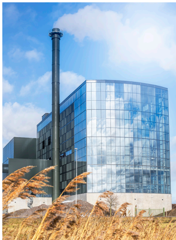
Tekniska verken i Linköping, Lejonpannan
