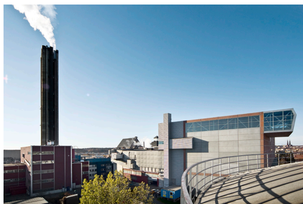
Vattenfalls kraftvärmeverk i Uppsala. Bildkälla: Vattenfall
