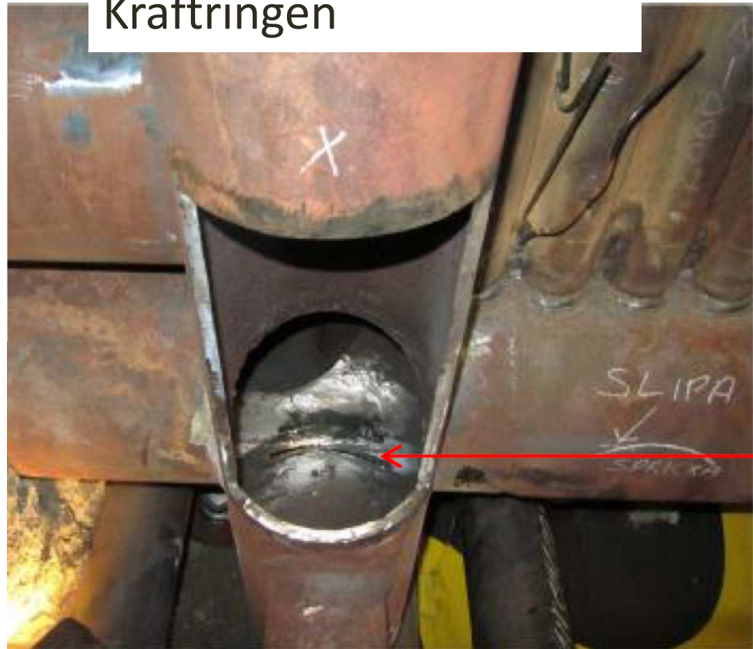
Bild 1. Rörkors med skada
