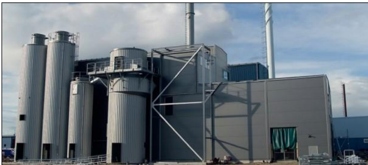
Munkfors Energis nya förgasningsanläggning kommer att producera 10 MW th och 2 MW el . Foto: Munkfors Energi
