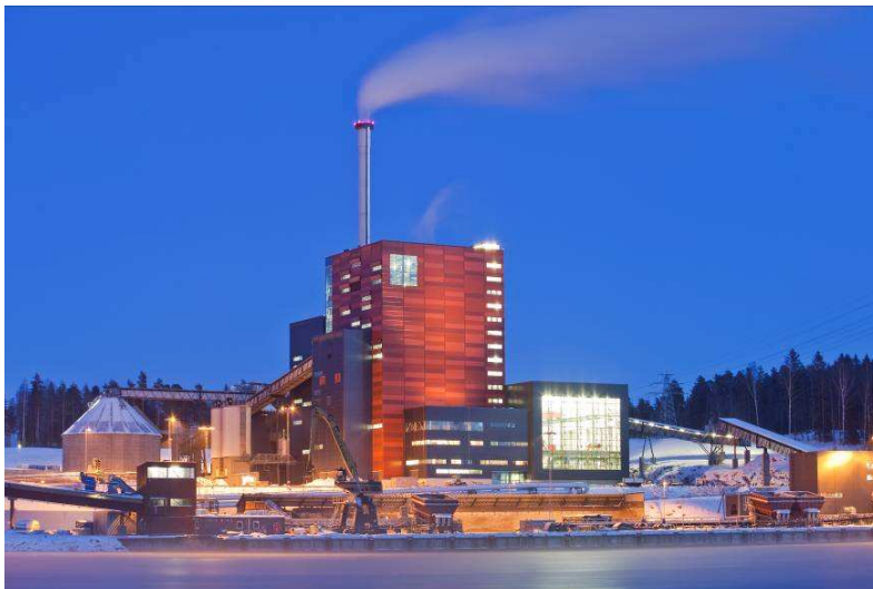
Söderenergis nya biobränsleldade kraftvärmeanläggning, Igelstaverket
