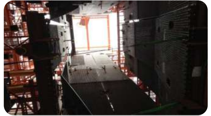
Eldstad, Botten med manifoldrar
