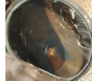
Läckage överhettare, bakre draget
