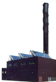
Kraftvärme och hetvatten
