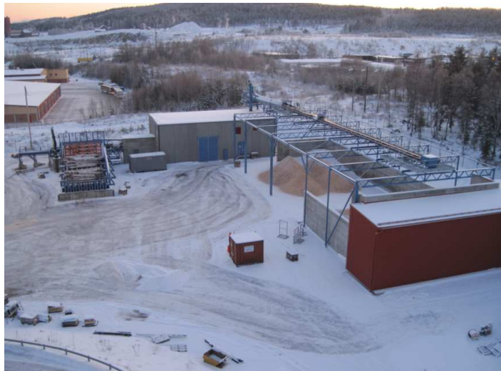
Flistugg och förråd till pannor och pelletsfabrik
