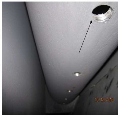
Spridar vatten rör efter uppborring
